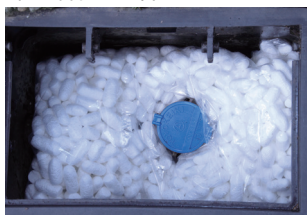
保温材を敷き詰める
