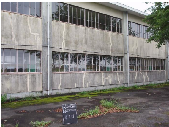
【川西小学校の外壁修繕工事の様子】
