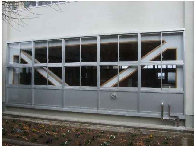
【耐震改修工事完了後の様子】
