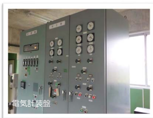
～ 老朽化が見られる機械電気計装設備（佐久山東部浄水場）～
