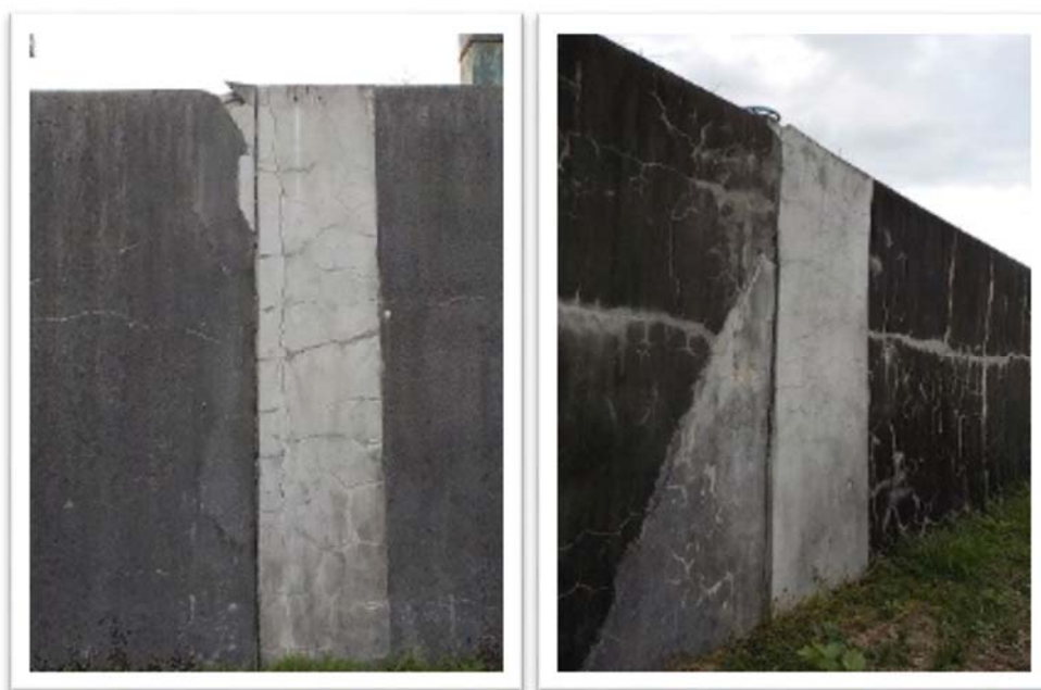
～ 被災した大田原配水池の応急処置状況 ～
