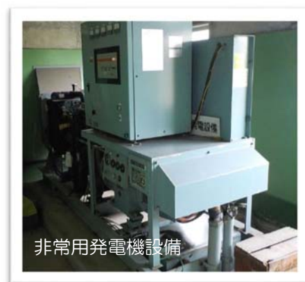
～ 老朽化が見られる機械電気計装設備（佐久山東部浄水場）～
