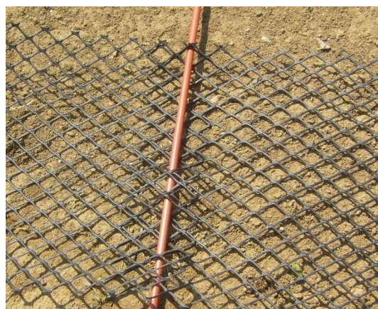
図20 ネットの継ぎ足し部
