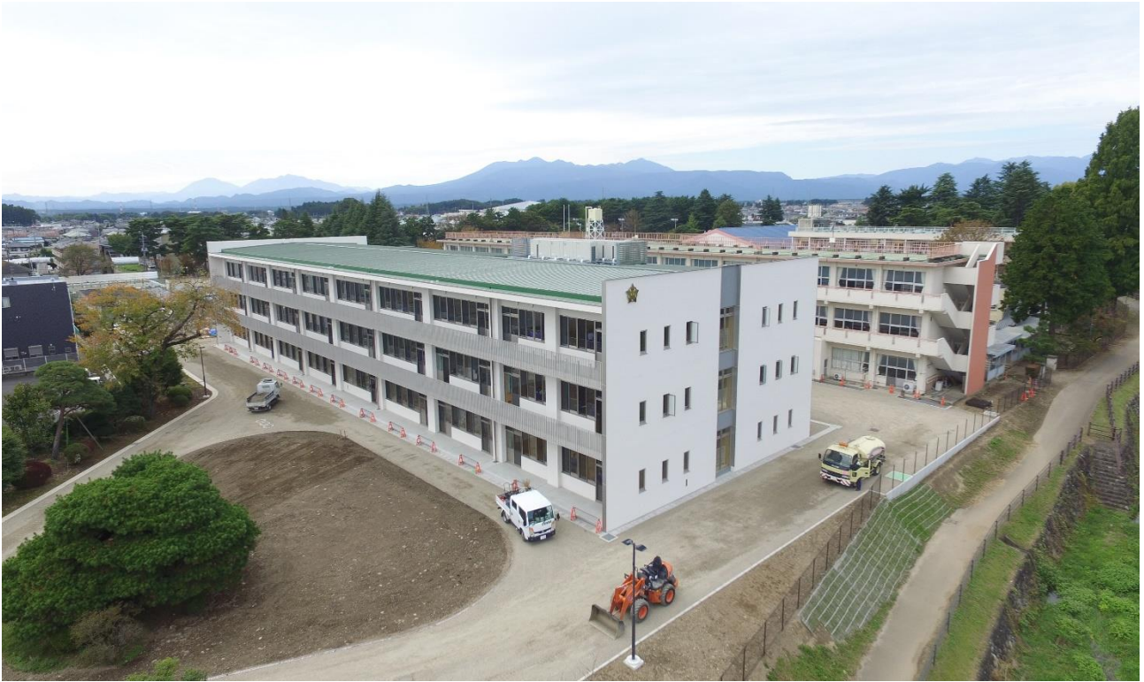
↑ 供用開始となった大田原中学校教室棟
