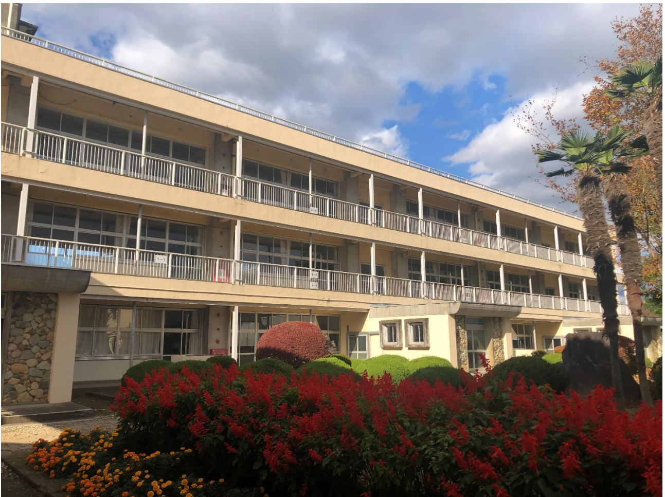
↓ 今後解体予定の旧教室棟
