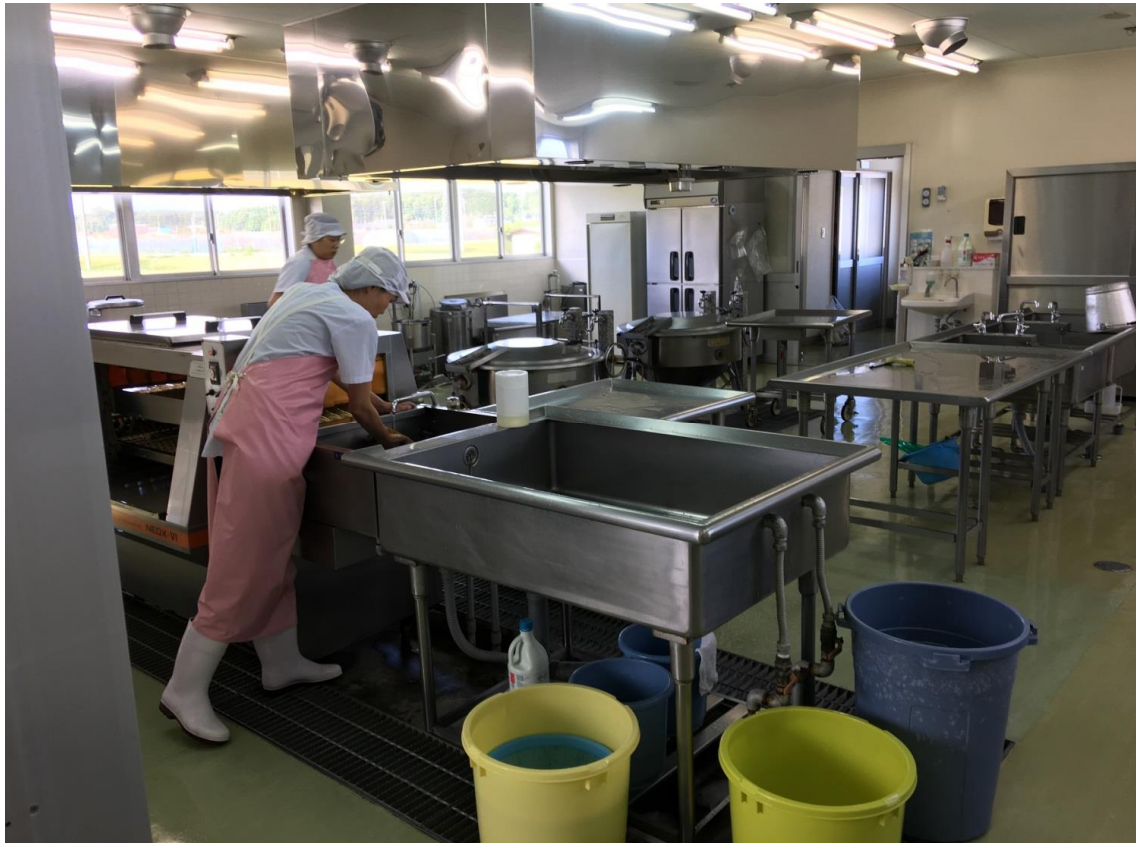
↑ 奥沢小学校 給食室の状況
