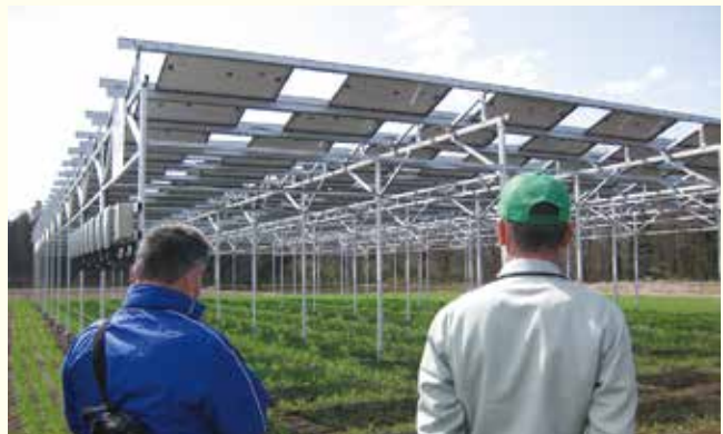
▲高さ4.25m、柱間3mの太陽光パネルを農地に設置
