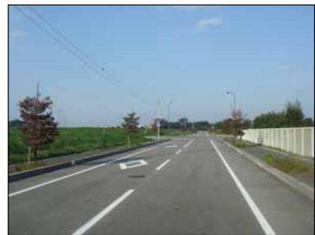
《基盤整備済みの中田原工業団地》
