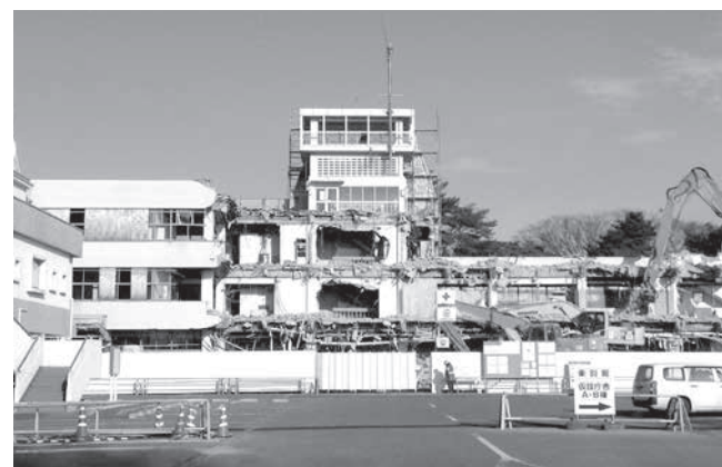
旧本庁舎の解体の様子
