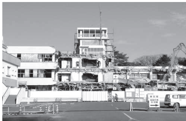
旧本庁舎の解体の様子
