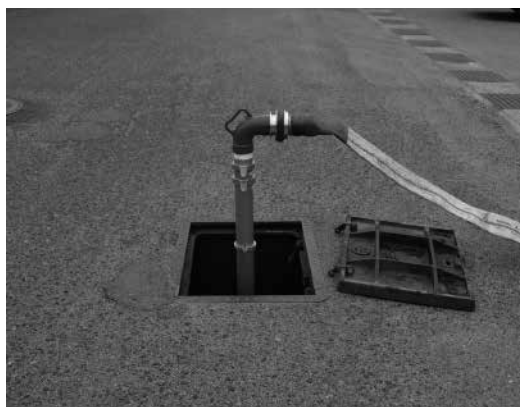
スタンドパイプ
