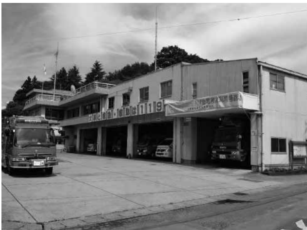
移転が決まっている現在の消防本部庁舎
