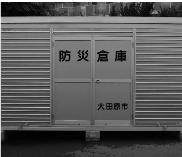
支援物資が備蓄してある防災倉庫(市役所)
