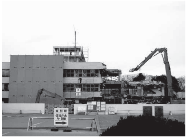
震災により使用不可能となったため、解体されている本庁舎
