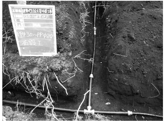
未給水地域への給水管布設工事の様子
