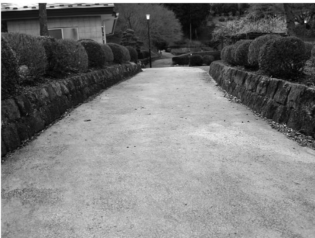
カラー舗装で整備された遊歩道
