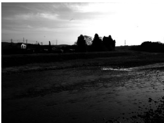
那珂川の堤防沿いには民家も建ち並び
