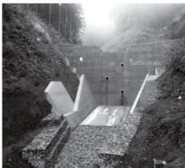
黒羽地区で進む砂防工事
