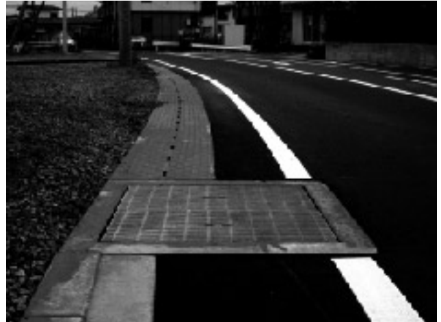
雨水排水計画に基づいて整備を行っています
