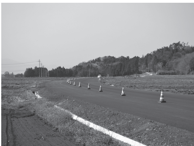
工事が進む市道宇田川佐良土線
