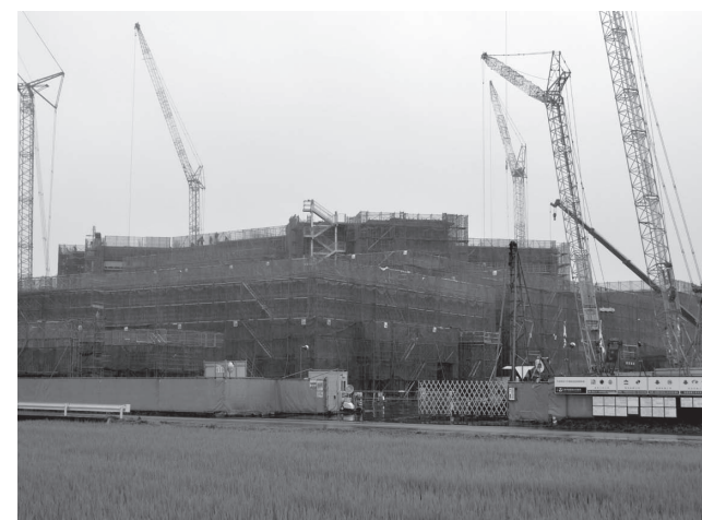
建設工事が進む大田原赤十字病院
