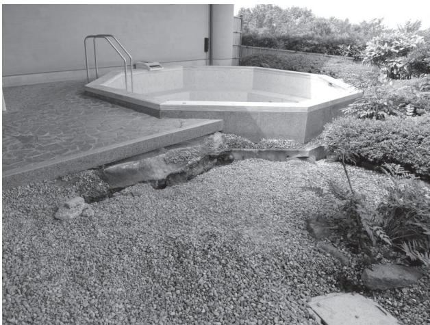
早い復旧、再開が望まれる黒羽温泉五峰の湯
