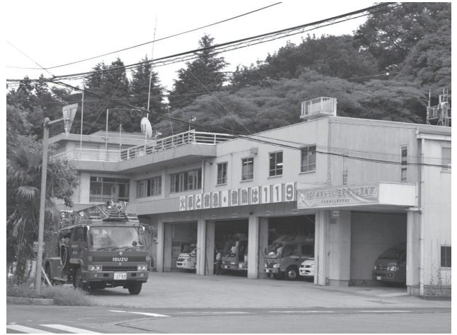
望楼を撤去した消防組合本部庁舎
