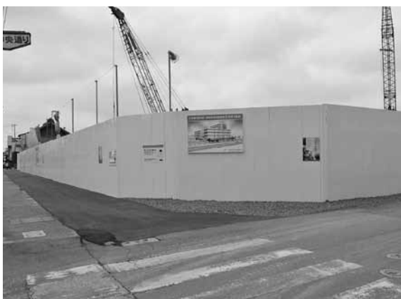
再開発ビルの建設工事が始まりました
