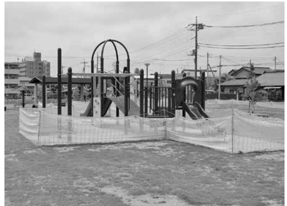
平成26年4月開園に向け工事中の（仮称）多目的公園
