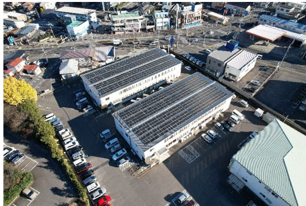
市役所本庁舎 A・B 別館太陽光パネル
