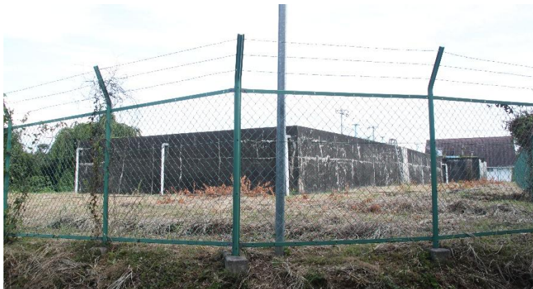
大田原配水場（中央が創設池 右奥が増設池）
