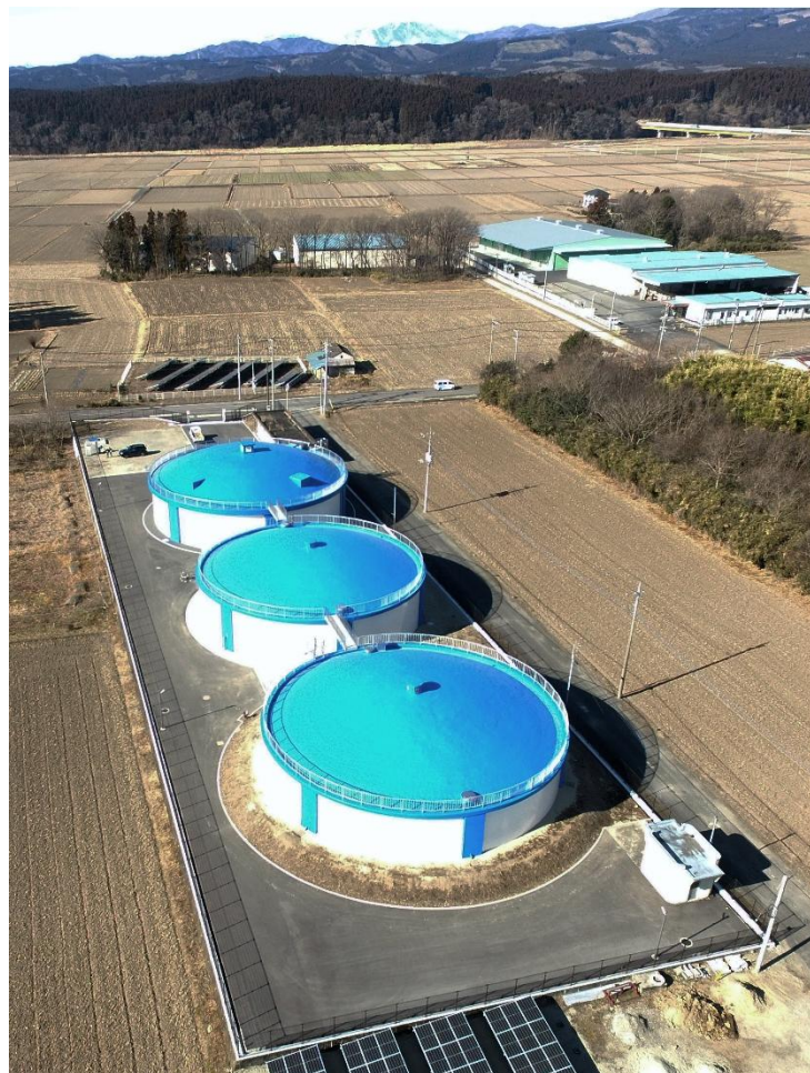
上石上配水場 (手前から1号) ※ドローン撮影
