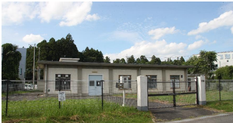
大田原浄水場（正面がポンプ棟）
