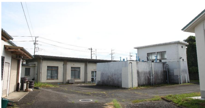
大田原浄水場裏側（中央右が浄水池と着水井）
