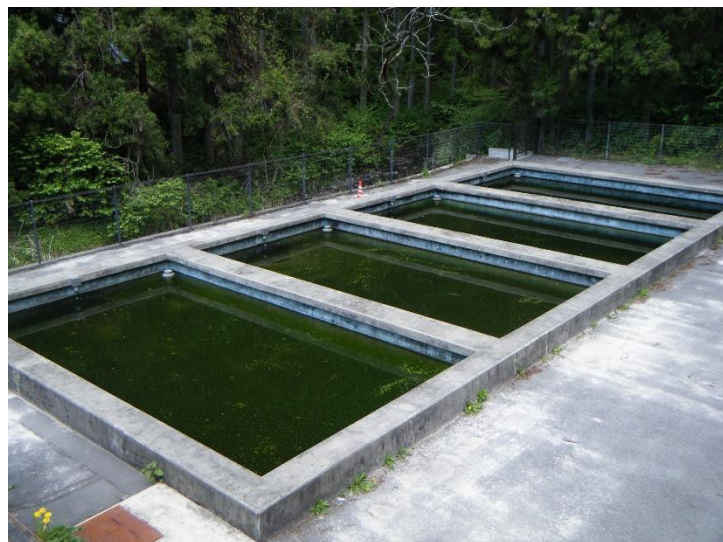
桧沢浄水場の緩速ろ過池
