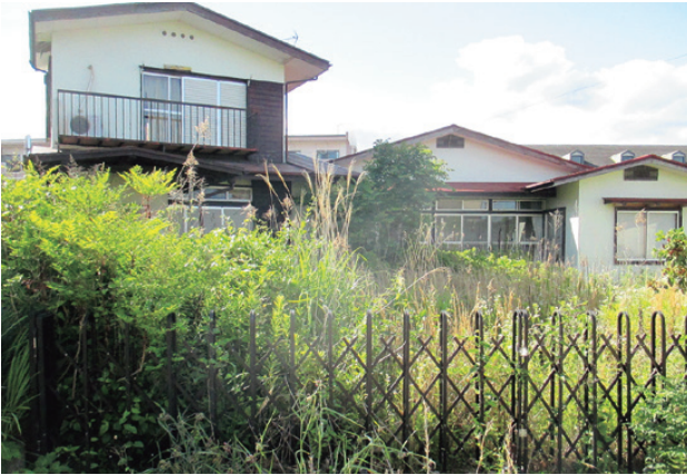
《草木が繁茂している空き家》
