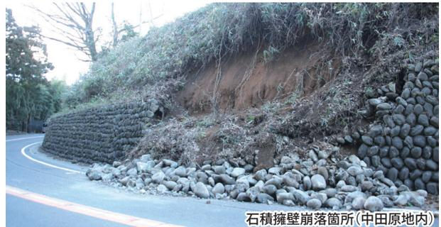
石積擁壁崩落箇所(中田原地内)
