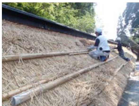
大雄寺廻廊屋根差茅修理
