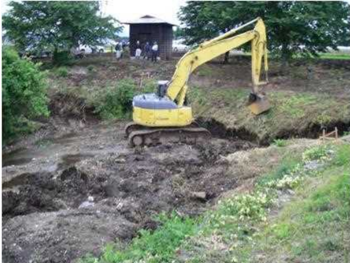
2009(平成21)年5月(工事中)
