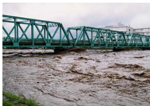
那須水害時（1998年）に那珂橋に迫る濁流
