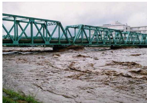
那須水害時（1998年）に那珂橋に迫る濁流
