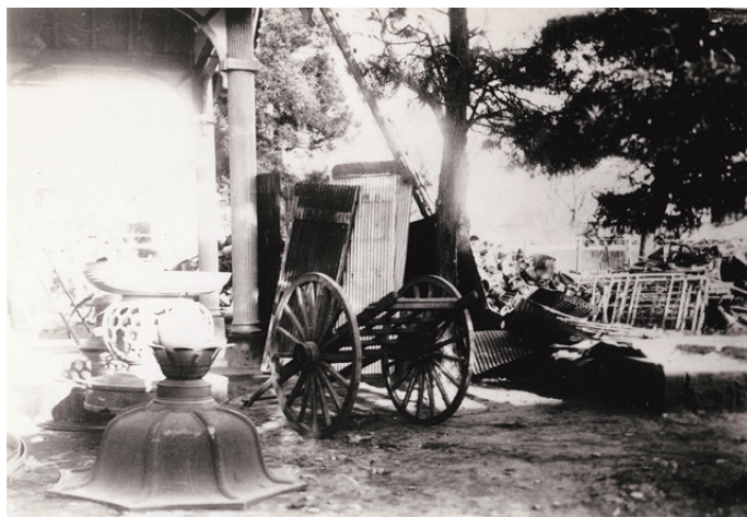
解体された金燈籠
