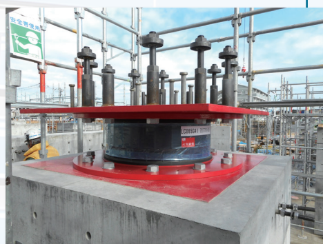
▶免震装置設置工事
