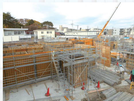
▶型枠工事、コンクリート打設工事
