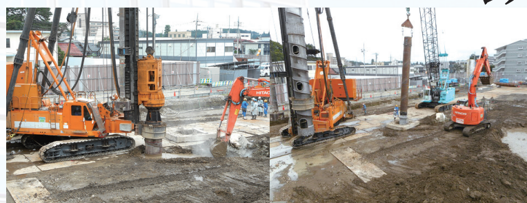
▶掘削作業、杭設置作業
