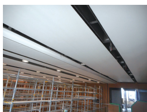
議場の膜天井（8階から撮影）
