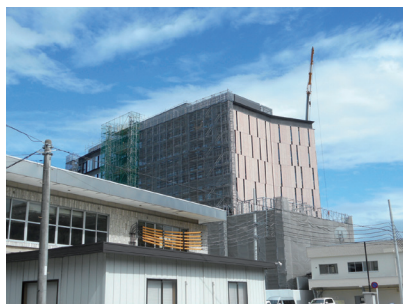
【新庁舎西側からの外観】
