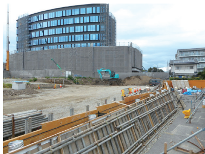
【外溝工事(通路)のようすと 新庁舎南側からの外観】
