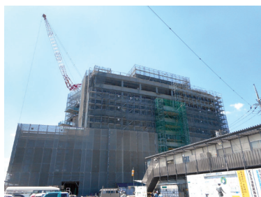
外部コンクリート壁(帯状)が取り付けられた建物 ※新庁舎北側から撮影
