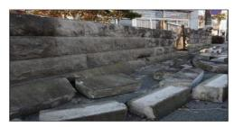
建築基準法では、ブロック塀等が倒壊しないための最低限の基準を定めています。ブロック塀 等の改修及び新設をする場合は、基準を守っていただくようお願いします。
