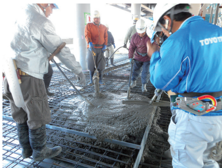
4階床部分のコンクリート工事の様子
