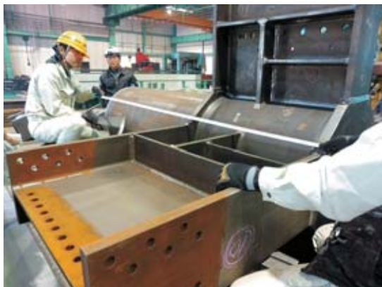
材料検査(鉄骨)のようす
