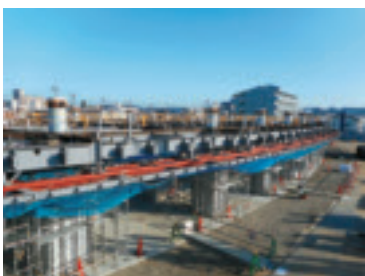
組み立てられた鉄骨 ※赤い鉄骨は1階の庇部分、上部の梁は2階の床部分になります。
