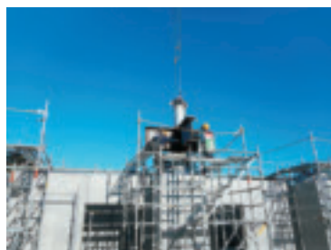
鉄骨工事の様子 ※大型クレーンを使用して設置します。
