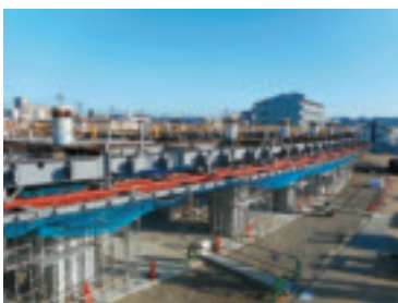
組み立てられた鉄骨 ※赤い鉄骨は1階の庇部分、上部の梁は2階の床部分になります。
