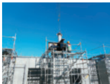
鉄骨工事の様子 ※大型クレーンを使用して設置します。
