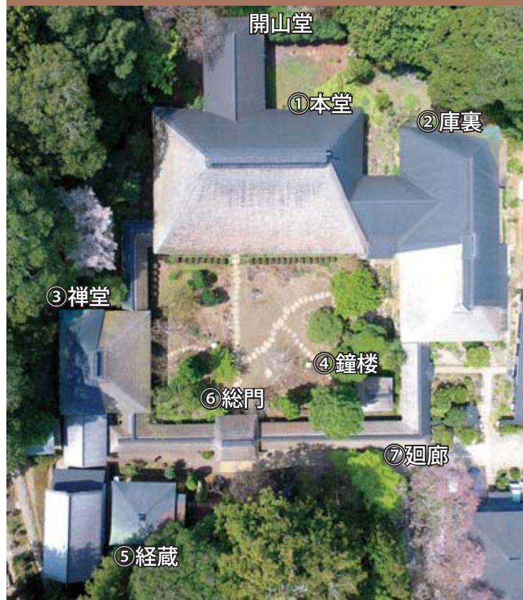
大雄寺境内全体写真
