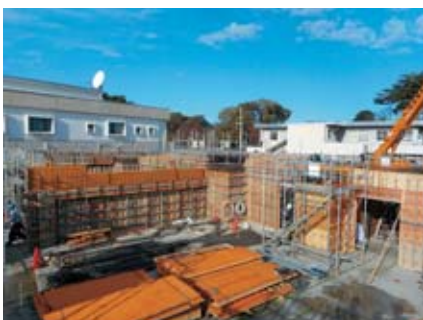
型枠工事の様子
