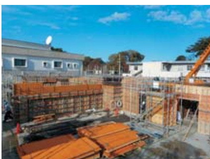
型枠工事の様子
