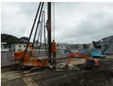
杭工事の様子
