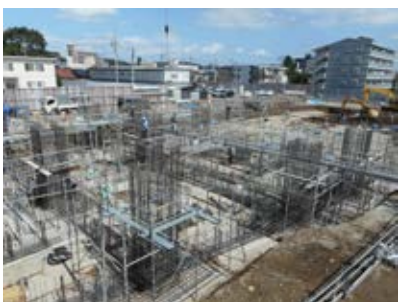
鉄筋工事の様子
