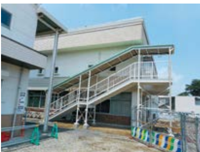
完成した議会棟仮設階段
