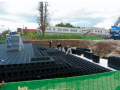
雨水浸透槽設置工事(南側)の様子
