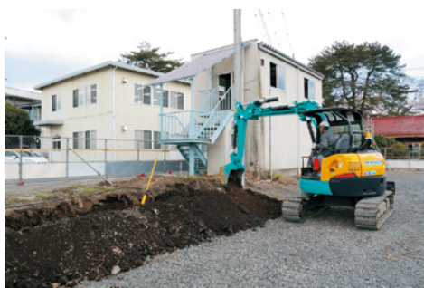
造成工事の様子
