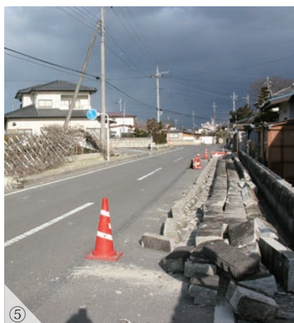
①地震発生直後の市役所本庁舎前／②佐久山地区、私道の地割れ／③黒羽城址公園内の土砂崩れ／④市役所本庁舎内部／⑤大田原地区、石塀の倒壊／⑥避難所での食事提供（湯津上農村環境改善センター）
