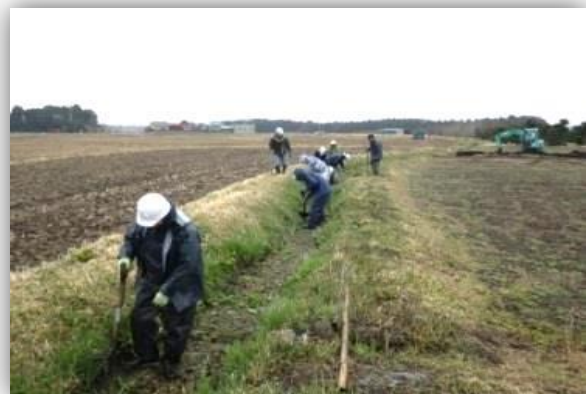
水路の泥あげ作業
