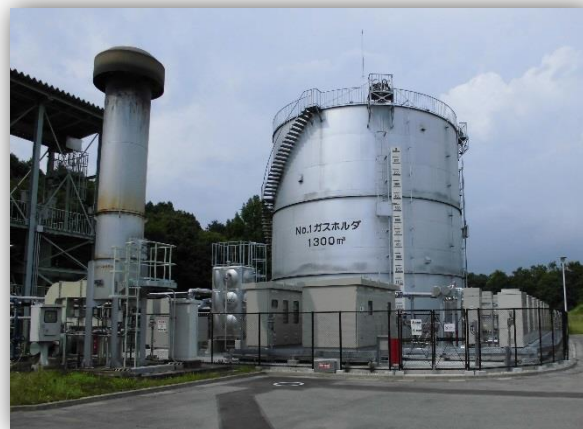
北那須浄化センター 消化ガス発電設備
