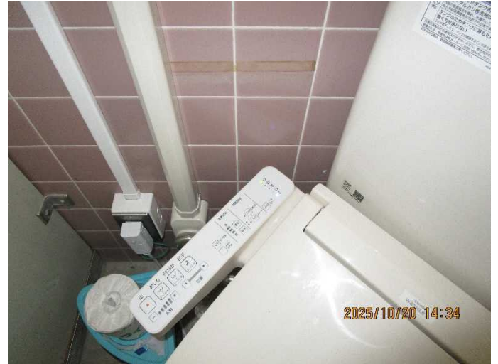
市野沢小学校 体育館トイレ
