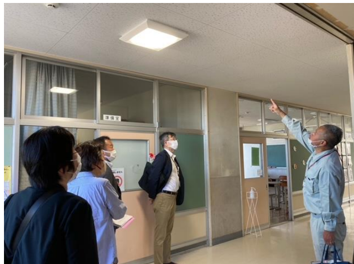
薄葉小教室棟天井の改修を確認
