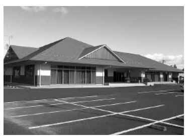
施設(平成15年建築) 多目的ホール、第1・2・3会議室、調理室、ロビー、グラウンドゴルフ場、ゲートボール場2面
